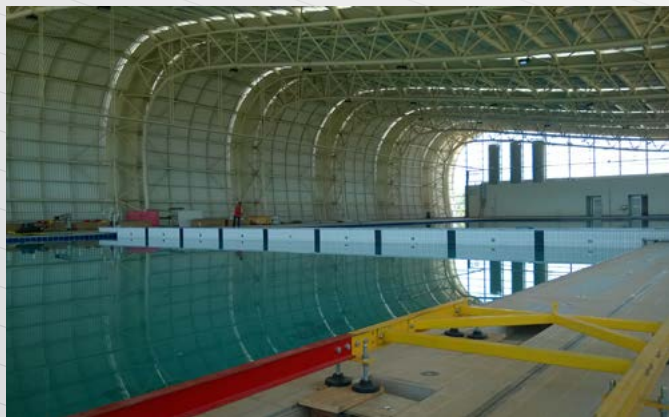
Foto: CTE Parque Aquático UFMG / instalação bulkhead (borda móvel)
