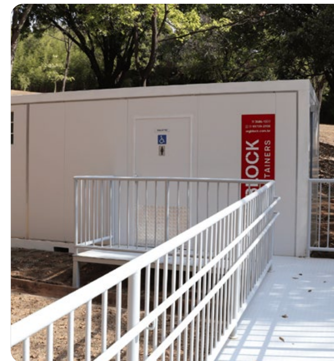
Foram instalados, na área externa do Ed. Sede, dois contêineres adaptados com estrutura de vestiário para uso pelos colaboradores que praticam atividades físicas. Acervo/Fundep
