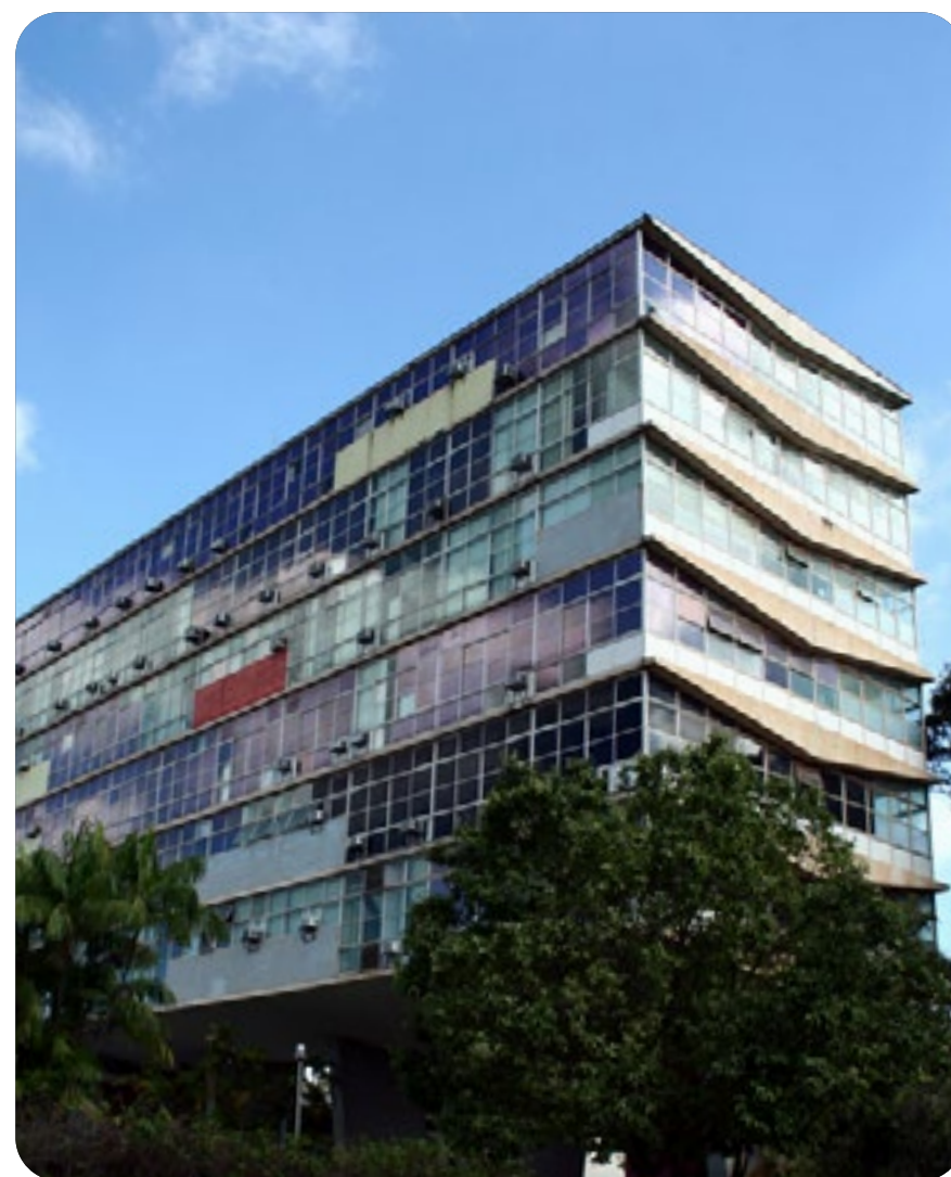
Prédio da Reitoria da UFMG, Campus Pampulha.
