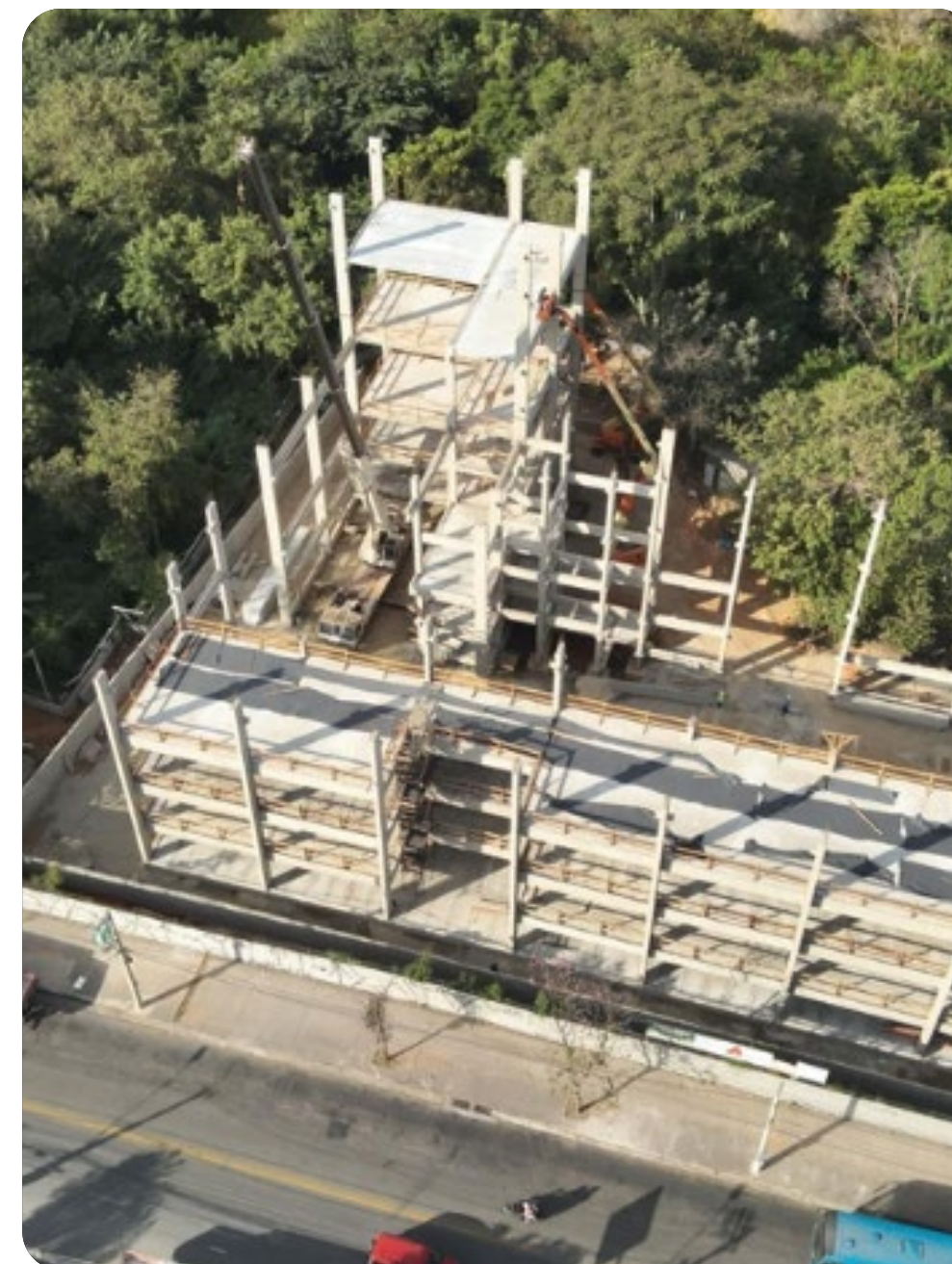
Obras do Centro Nacional de Vacinas no BH-Tec. Acervo/Fundep
